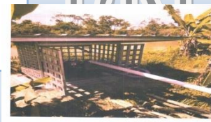
Gambar 1.4 Rumah Pompa di BBIS Pemali
