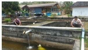
Gambar 1.3 Instalasi konstruksi jaringan air di BBIS
